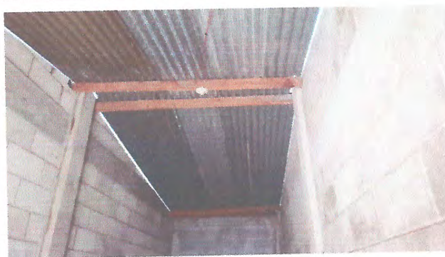
Foto 4: MEJORAMIENTO DE ENTECHADO DE BODEGA
