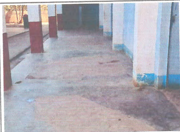
Foto 3: MEJORAMIENTO DE PISO DE AULAS Y CORREDOR DE LA ESCUELA
