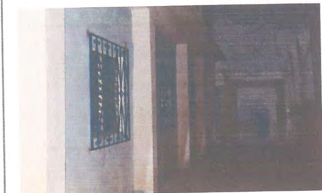
Foto 1: MEJORAMIENTO DE VENTANALES
